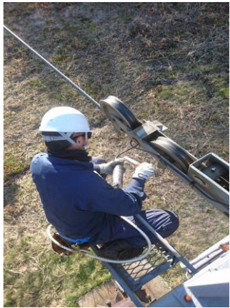
各運行リフト支柱点検整備
